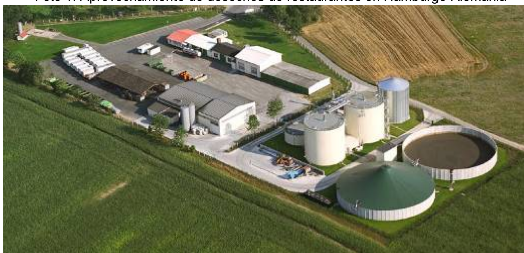
Diseño y construcción ENTEC GMBH, Austria – Grupo Aqualimpia
